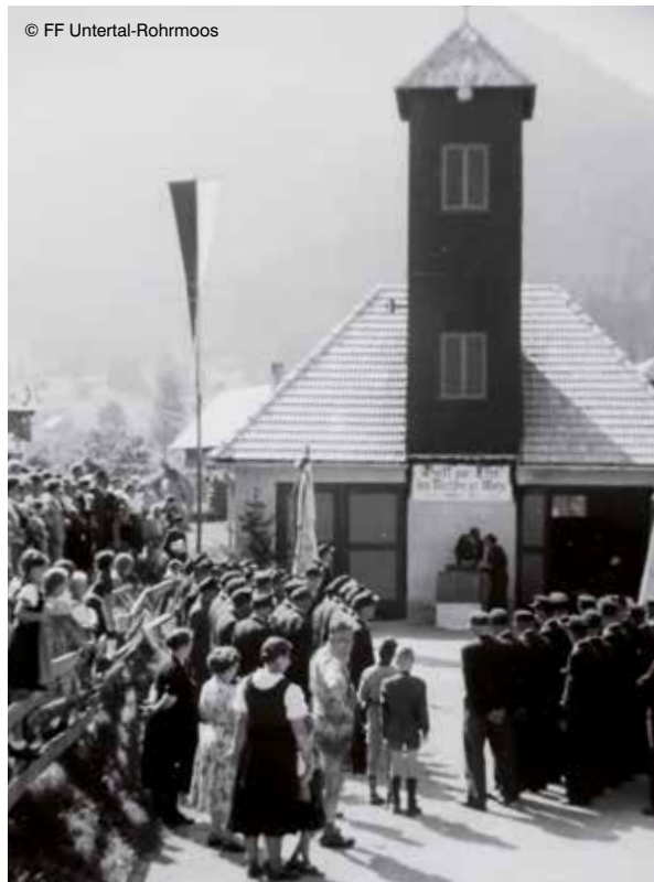
Die ersten Jahre nach der Gründung waren von intensiver Aufbauarbeit bestimmt. Neben der Anschaffung von Gerät und Uniformen war vor allem der Bau eines Rüsthauses 1954 eine wichtige Leistung. Das Bild zeigt die Einwei- hung 1955 unter reger Beteiligung der Bevölkerung.
