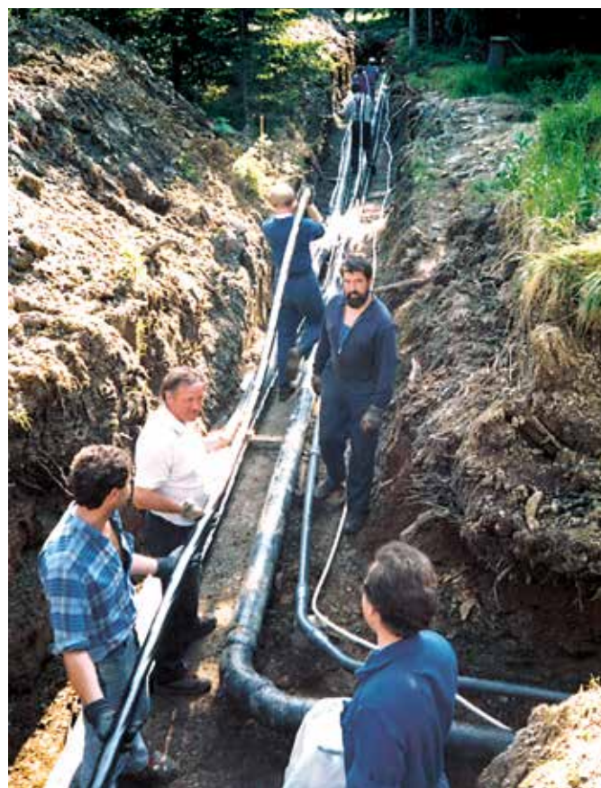
Mit der fortschreitenden Entwicklung der Schneeanlagen wurden die Zuleitungen unterirdisch fix verlegt.
